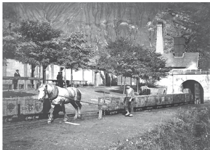
Fig. 6. Sortie d'une descenderie – Carrière Sainte-Aline
