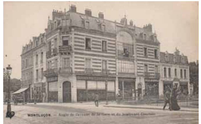
À l'angle de l'avenue de la gare et du boulevard de Courtais
