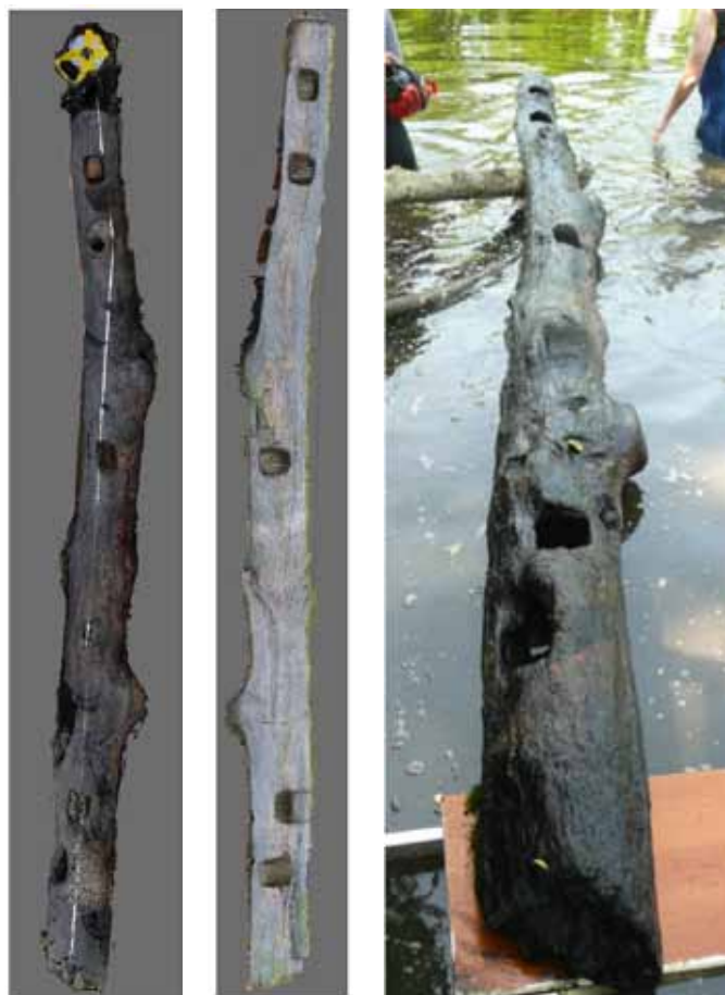
Sablière-basse taillée dans un tronc d'arbre (VIII e -IX e s.)
