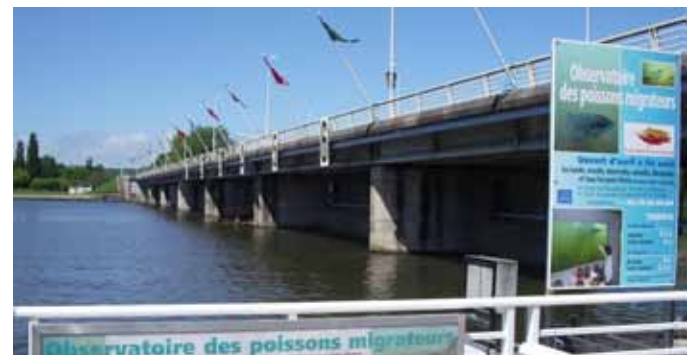
Pont-Barrage actuel (Coulon 1963), côté Observatoire des poissons migrateurs
