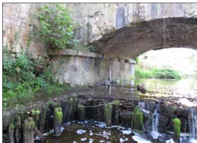
Fig. 6 : radier, pieux et palplanches du pont-canal de Chantemerle (Cl. SIEMECCB)
