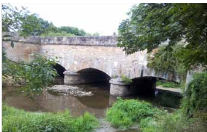
Fig. 2 : le pont canal de Chantemerle - Vaux (Cl. SIEMECCB)
