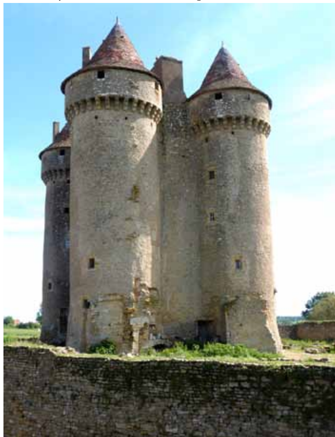
Château de Sarzay : vue sur le corps de logis avec au premier plan le mur des douves
