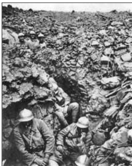
Les tranchées de Verdun
