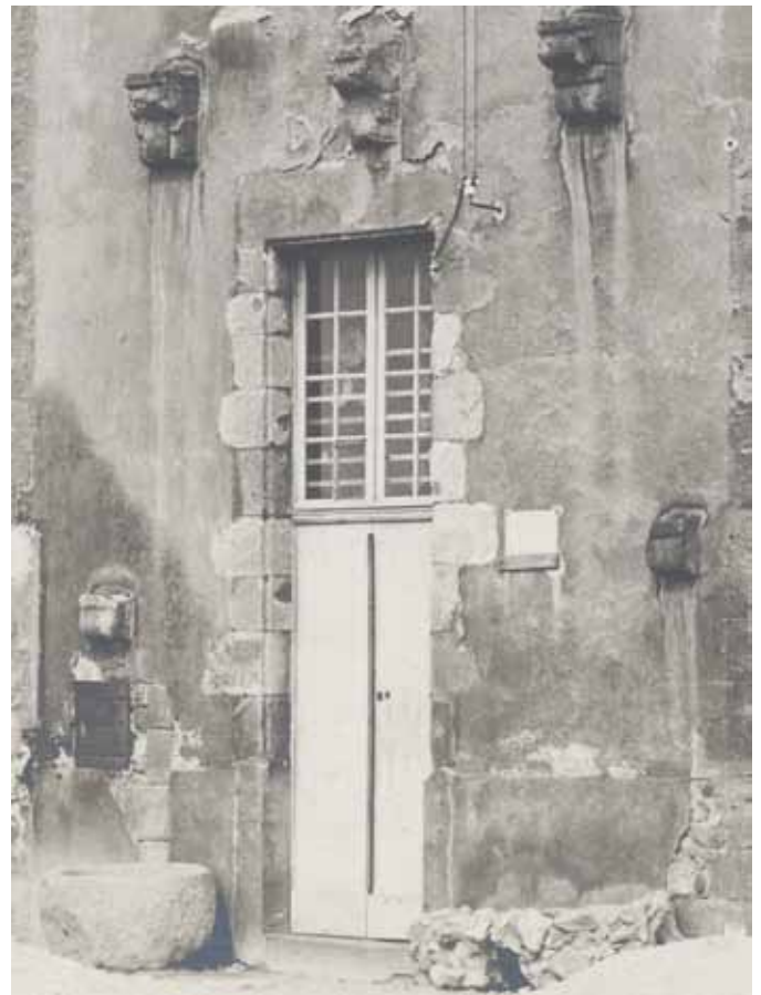
Sur cette photo on aperçoit au-dessus de la porte derrière les vitres quelques éléments de la collection de faïences de J.M. Clément
