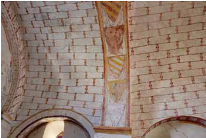
Église Saint-Éloi de Vitray : les armoiries sur l'un des arcs et la voûte en faux appareil à trous de louve
