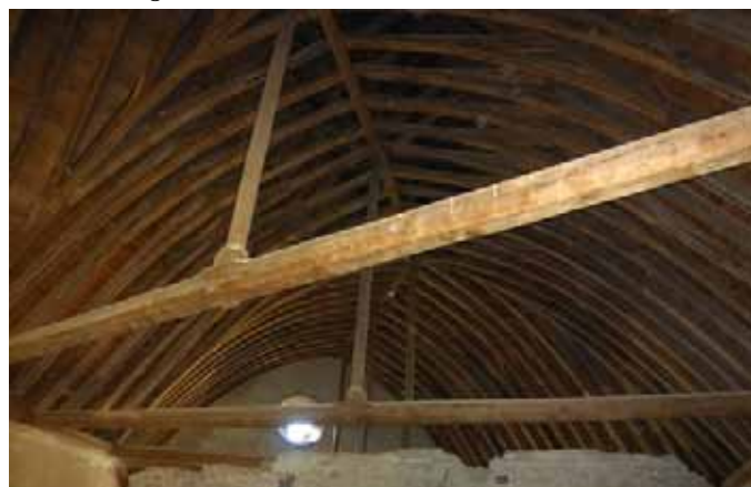
Château de La Condemine : vue de la charpente
