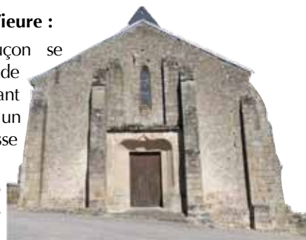
Vieure : la façade occidentale
