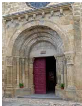
Buxières-les-Mines : le porche de l'église Saint-Maurice
