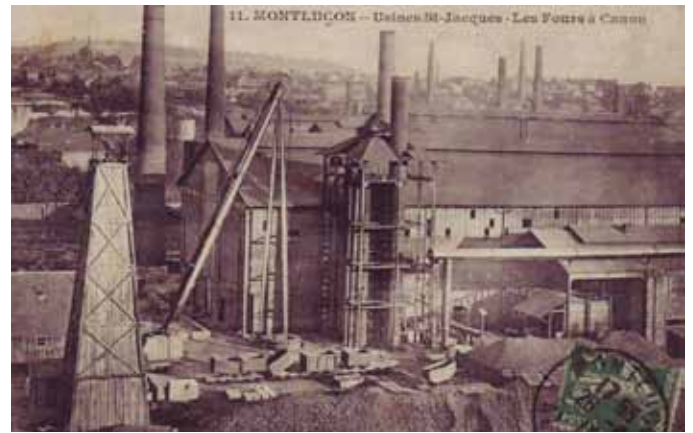
Usine Saint-Jacques : les fours à canons
