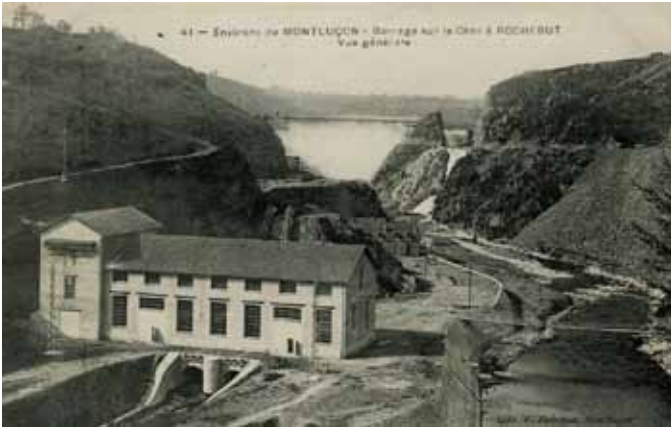
Le barrage de Rochebut
