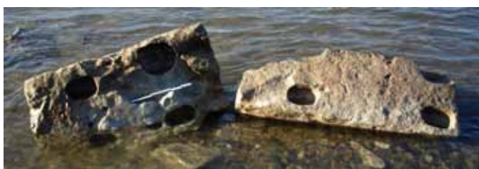
Blocs techniques de supports des roues d'entraînement hydrauliques
